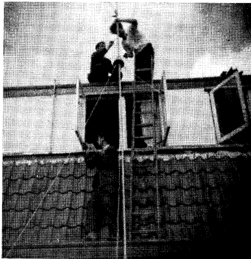
De antenne van PAoDIC. Dit is een foto van de oprichting van de antennemast van PAoDIC in Hilversum. De mast is negen meter lang met bovenin de long Yagi voor 70 cm (beschreven in Electron) en 1½ meter lager de WISA-Click. Op de foto ziet u PAoJPH (links boven), PAoDIC (rechts) en in de dakgoot PAoMW. De overige (onmisbare) helpers, niet op de foto, waren PAoZE en OM Bente Bordes. Toeschouwers waren de x.yl van PAoJPH en de QRP. De thee en de foto: mevr. Sauer
